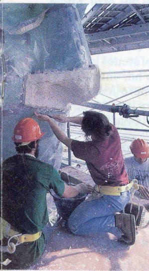
Frihetsstatuen er gjenoppbygget. Etter å ha vært utsatt for elementenes påkjenninger, trengte kobberkledningen en rengjøring pluss enkelte reparasjoner hist og her.
