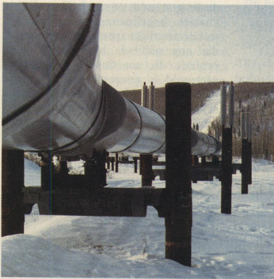
De Alyeska pijpleiding bij Fairbanks in Alaska, halverwege de weg van Prudhoe Bay naar Valdez.
